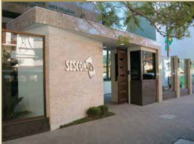
Fachada Centro de Eventos
